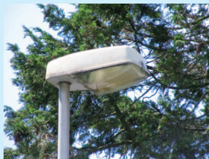
Le revêtement en verre de ces luminaires est translucide et courbe (globe opaque). Ils diffusent donc la lumière de façon incontrôlée. Le verre transparent plat ou légèrement courbé est plus adapté.
